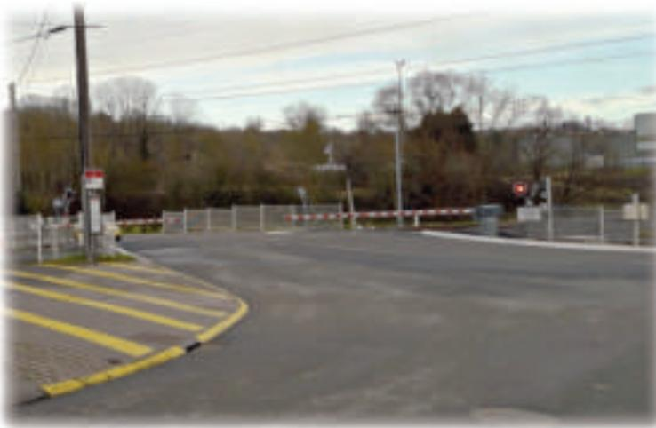
En octobre la SNCF a engagé des travaux sur le passage à niveau de la rue de la cimenterie, élargissement et remplacement de la bande de roulement pour une diminution du bruit et une sécurité accrue au passage des camions.
