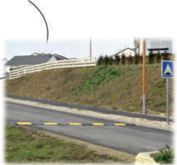
Le ralentisseur route de Maizières préalablement démonté pour permettre le passage de l'alimentation électrique a été reposé. Certains éléments abîmés ont été remplacés.
